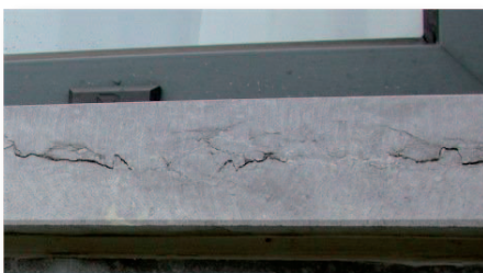
Afb. 1 Zwarte lijn (stylolieten in de dwarsdoorsnede van het element)
