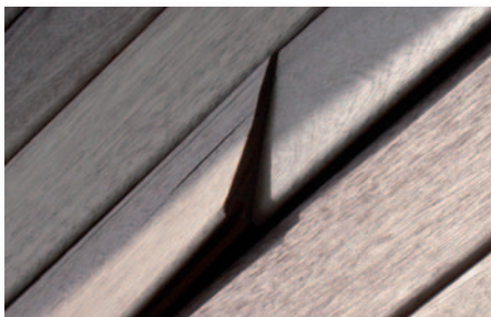
Afb. 2 Uiteenschuiven van de tand- en groefverbinding
