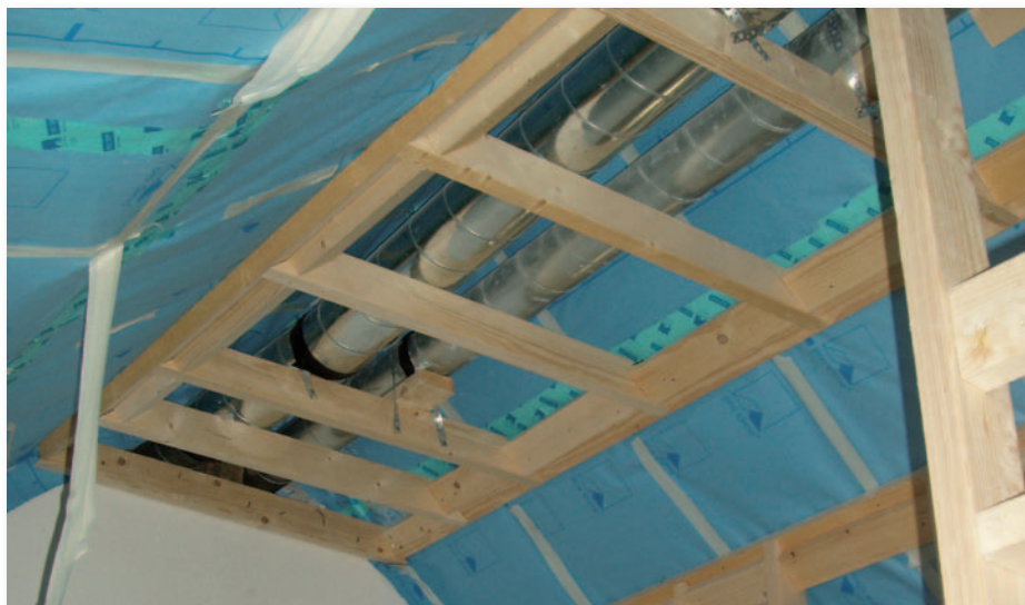
Afb. 1 Wegwerken van kanalen in verloren ruimten
