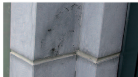
Afb. 2 Zwarte vlek (stylolieten doorlopend tot in het zichtvlak van het element)
