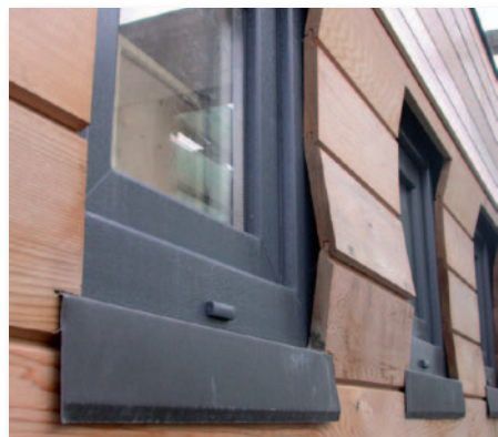
Afb. 1 Uitgesproken dimensionele vervorming
