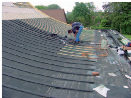
Afb. 1 Uitvoering en opbouw van een pannendak met een flauwe helling
