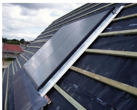
Abb. 2 Einbau von Solarkollektoren in ein Schrägdach.
