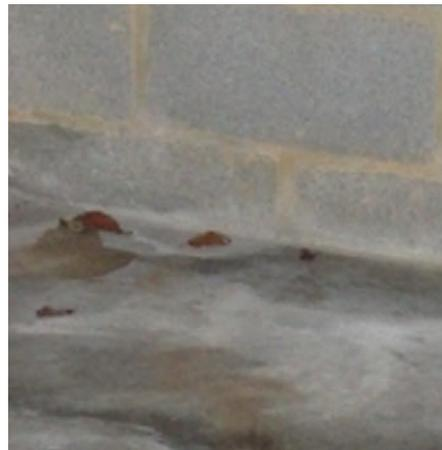
rungsputze, ...) in Erwägung ziehen. Diese Behandlungen werden sehr oft ergänzt durch antikapillare Injektionen (Innen- und Außenmauern) und die Ausführung eines neuen Fußbodens auf einer wasserdichten Membran.
