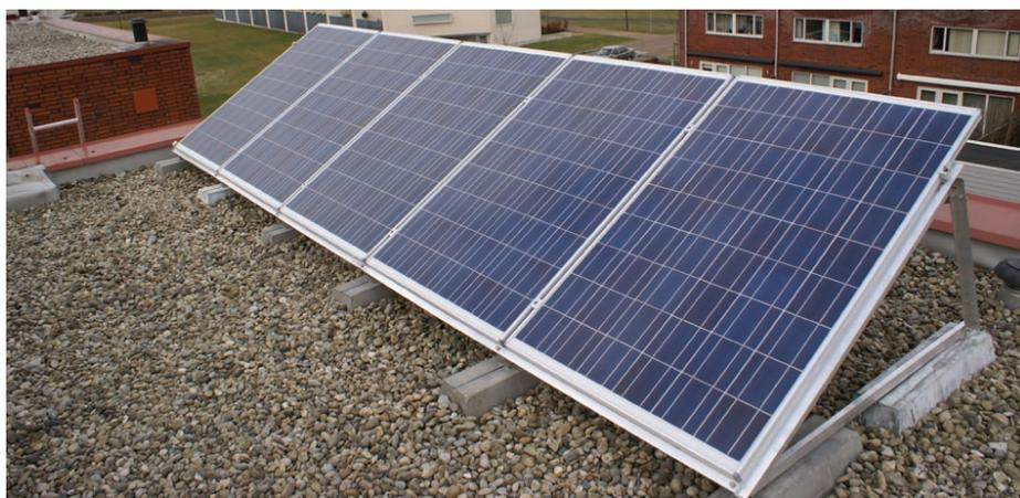
**Abb. 3** Der Wirkungsgrad der Anlage lässt sich durch eine gute Belüftung der Rückseite steigern.
