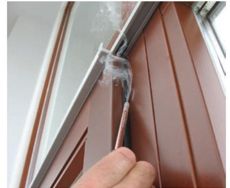
Abb. 2 Lokalisierung eines Lecks mithilfe eines Spurengases.
