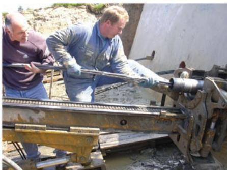
Abb. 1 Installation der Erdanker.
