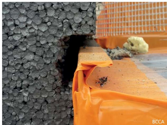
**3** | Pose inadéquate des bandes d'étanchéité précomprimées : absence de bande à la jonction entre l'isolant et le seuil, et découpe non ajustée de l'isolant.
