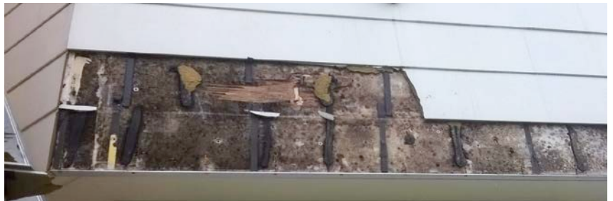
1 | Pathologie imputable à une conception défectueuse et/ou à une exécution incorrecte
