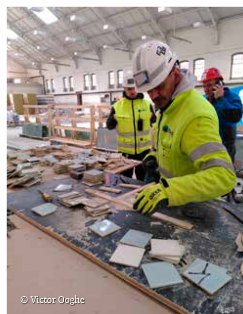
Usquare Brussel - tegels herstellen en hergebruiken
