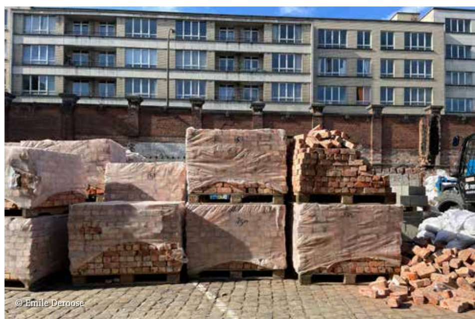
Usquare Brussel - bakstenen palletiseren op de site
