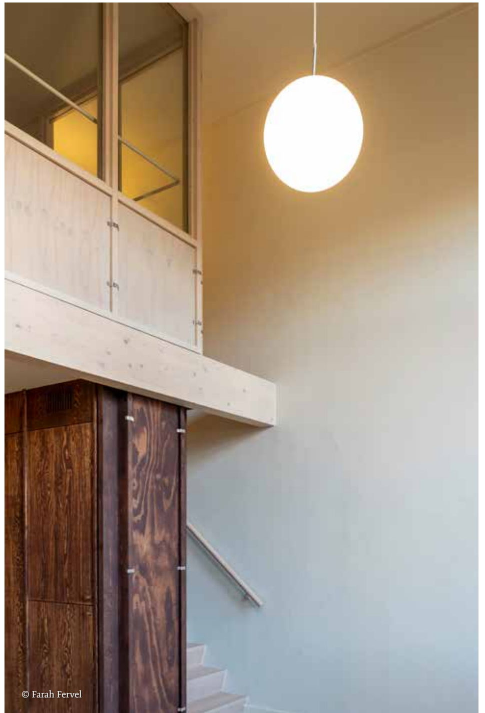
Usquare Brussel - nieuw binnenschrijnwerk met recup buitenbeglazing
