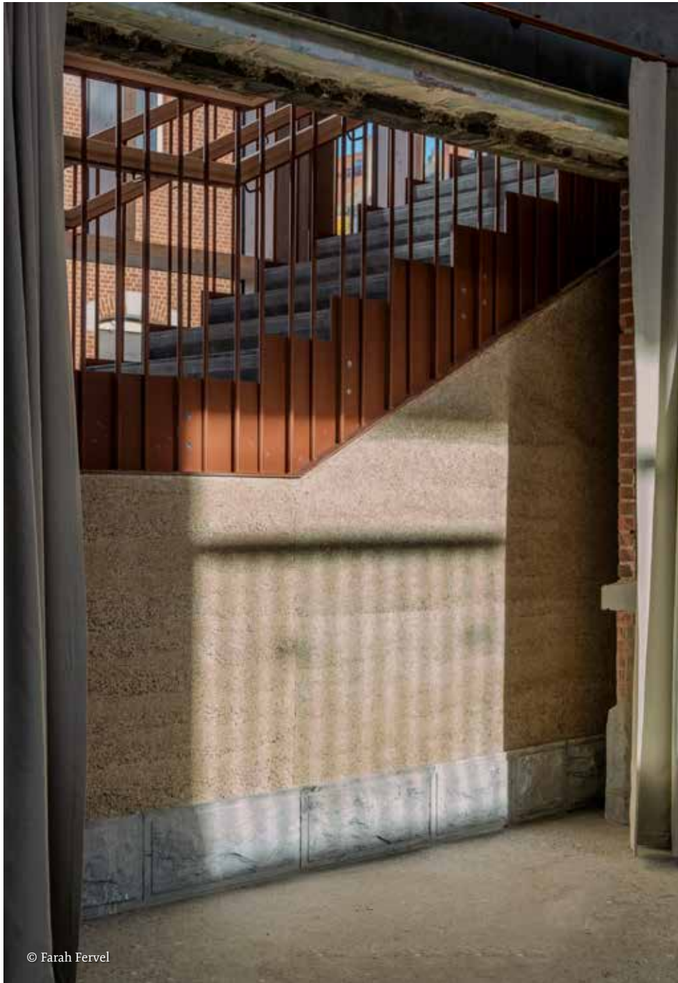
Usquare Brussel - trap op kalkhennepwanden met recup natuursteenplint
