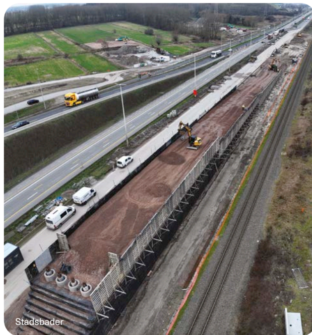
3 Vue aérienne du remblai renforcé construit avec des granulats recyclés comme matériau de remplissage dans le cadre des travaux du ring 4 de Gand.
