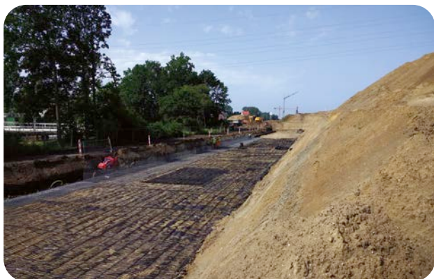
2 Construction d'un remblai renforcé au moyen de géogrilles.
