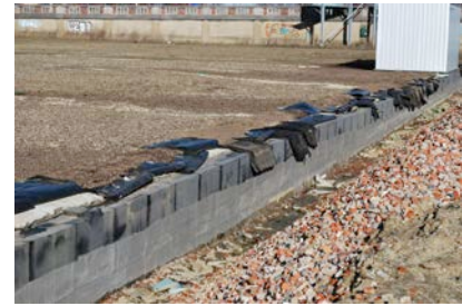
2 | Toepassing van een vloeibare afdichting
