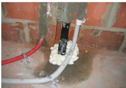
**Abb. 1** Abdichtung eines Fußbodendurchbruches, vor der Anbringung der Wärmedämmung.
