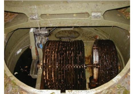
**Biorotor für die individuelle Wasserreinigung.**
