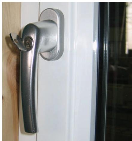
verzinktem Stahl, mit Knopf oder Schlüssel verriegelbarer Griff (Abbildung 1) mit Gehäuseaufbohrschutz, einbruchverzögernde Verglasung, ...
