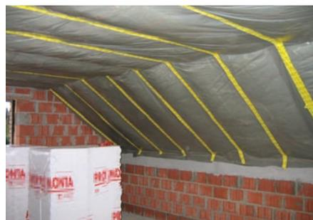
**Abb. 2** Luftdichtheit des Daches, realisiert durch das Festheften einer Polyethylenfolie am Gebälk.
