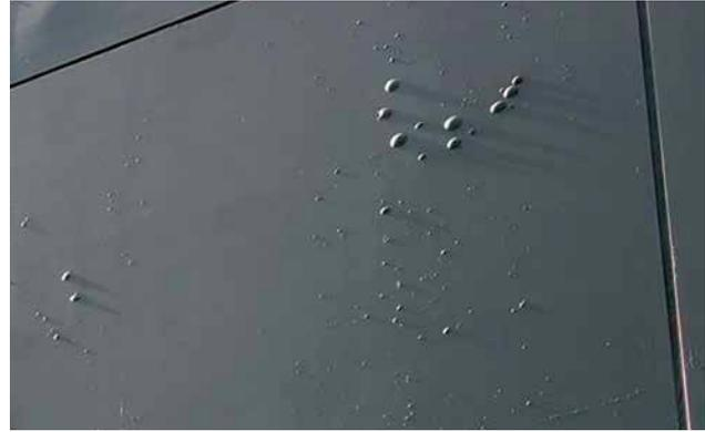
2 | Blasenbildung an der Oberfläche eines dunkelfarbigen Farbenstrichs, der auf einen Betonuntergrund angewendet wurde.
