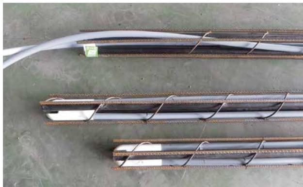
1 | In einem Armierungskorb befestigter Wärmeaustauscher mit vorgeformter U-Schleife.
