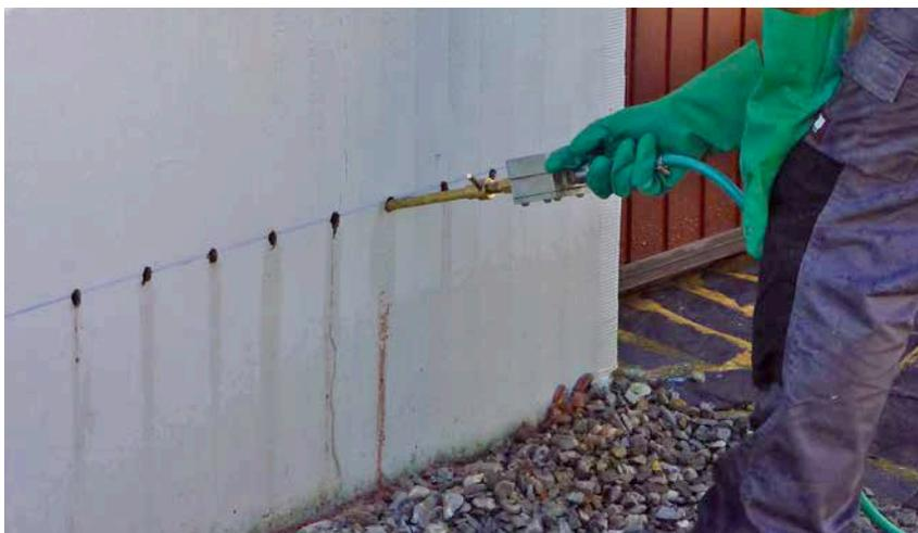
1 | Ausführung einer Injektionsbehandlung gegen aufsteigende Bodenfeuchtigkeit.
