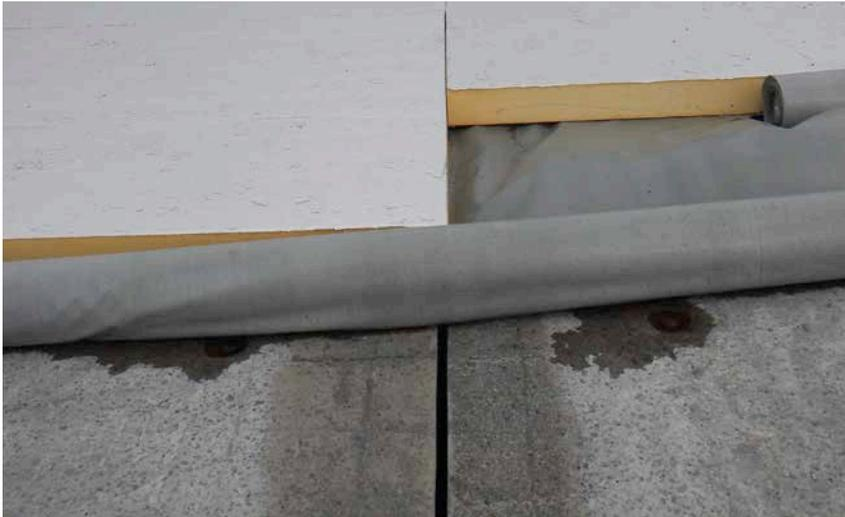
2 | Ausführung der Dampfsperre auf TT-Elementen.
