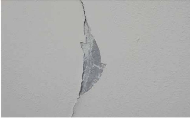
1 | Beschädigung eines Alkydanstrichs, der auf einen nichtkarbonatisierten Betonuntergrund und bei Vorhandensein von Feuchtigkeit angewendet wurde.
