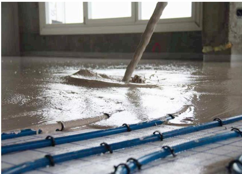
Ausführung eines Estrichs auf Calciumsulfat-Basis.
