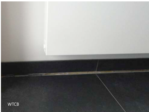
2 en 3 | Diverse schadegevallen die vastgesteld werden ten gevolge van een zetting van het gespoten polyurethaanschuim.
