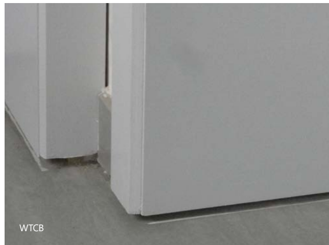
2 en 3 | Diverse schadegevallen die vastgesteld werden ten gevolge van een zetting van het gespoten polyurethaanschuim.
