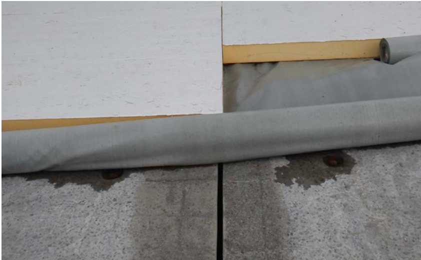
2 | Uitvoering van het dampscherf op TT-elementen.
