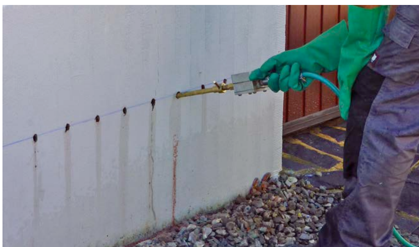
1 | Uitvoering van een injectiebehandeling tegen opstijgend grondvocht.
