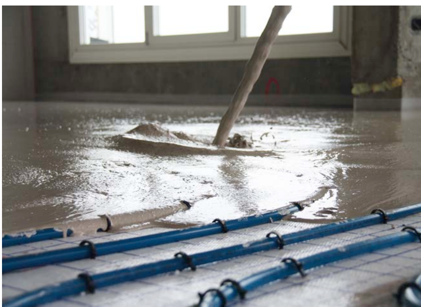
Uitvoering van een calciumsulfaatgebonden dekvloer.
