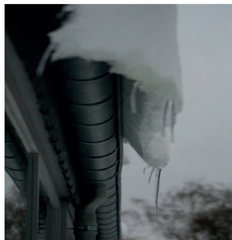
Afb. 1 en 2 Als gevolg van de accumulatie van sneeuw en ijs in de dakgoot zal deze uiteindelijk afbreken.
