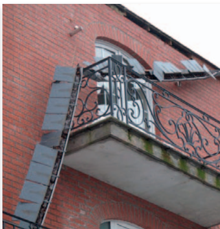
Afb. 1 en 2 Als gevolg van de accumulatie van sneeuw en ijs in de dakgoot zal deze uiteindelijk afbreken.
