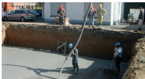
De plaatsing van ZVB vergt veel minder mankracht
