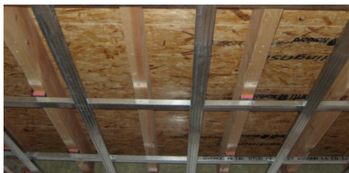
Afb. 4 Verlaagd plafond bevestigd aan een metalen regelwerk dat ontkoppeld werd van de draagvloerconstructie
