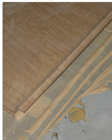
Afb. 1 De aard van de lijm oefent een reële invloed uit op de contactgeluidsisolatie van de vloeren
