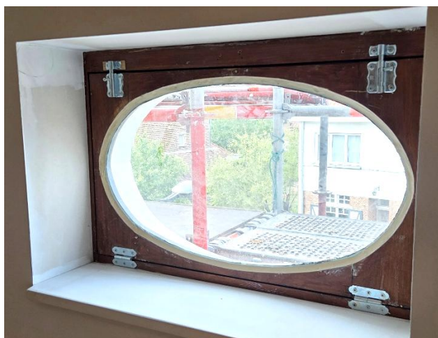
FIGURE 13. CHÂSSIS DE TYPE « CEIL DE BŒUF » APRÈS RESTAURATION
