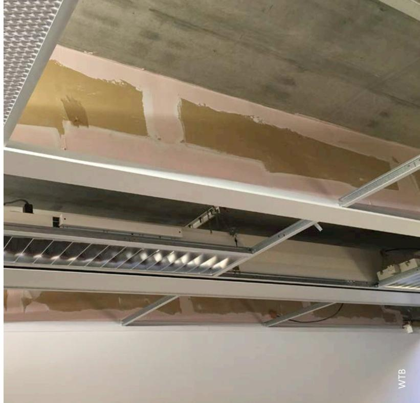
2 | Feststehende Brandschutzbarrieren, die in einem regelmäßigen Abstand im Luftraum einer abgehängten Decke angebracht werden.
