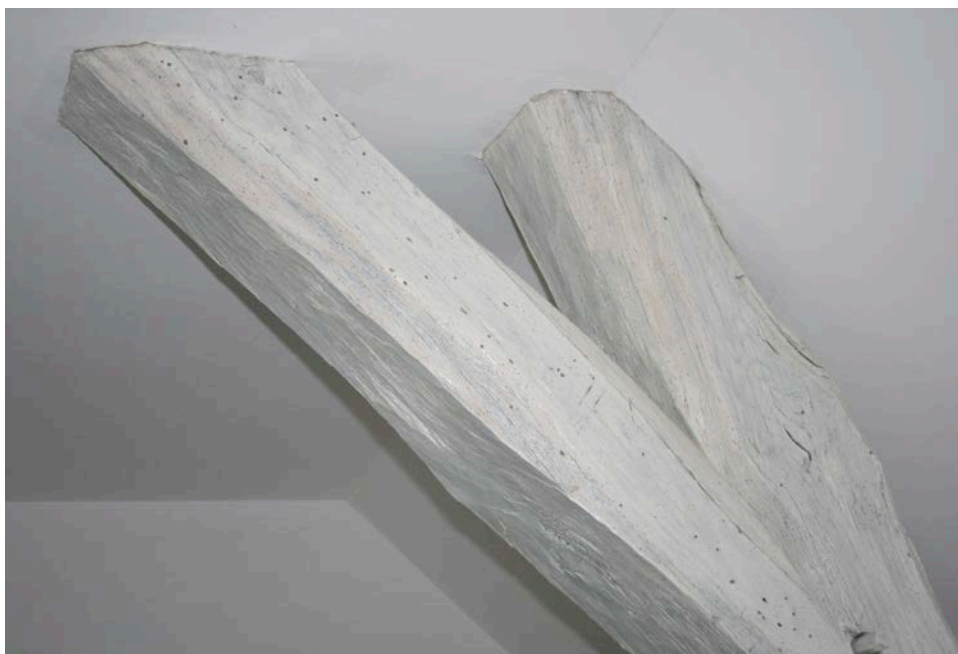
2 Aantasting van het hout door insecten.
