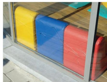
Abb. 2 Beispiel eines thermischen Bruchs durch den Einfluss der inneren Umgebung.
