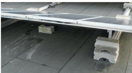
Abb. 1 Abrutschen der Photovoltaikpaneelen.
