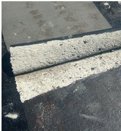
2 | Pulvérulence de la couche de surface d'une forme de pente à base de ciment
