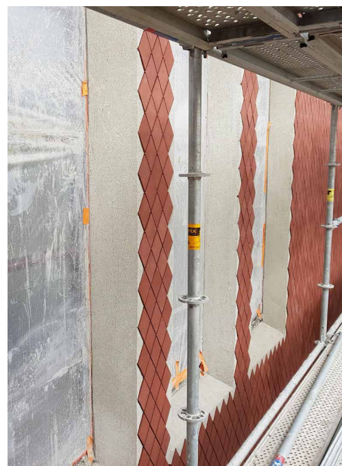
▼ De landmeter zette zowel de kaders als de positie van de bakstenen uit: een ingewikkelde puzzel met veel referentiepunten.
