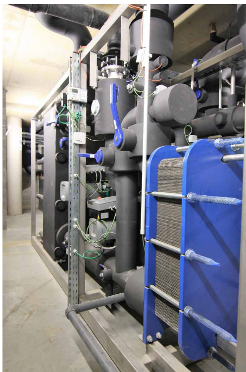
▲ De productiecentrale met warmtepomp, bron- en circulatiepompen en buffervaten werden bijna volledig in het atelier van Iftech geassembleerd.
