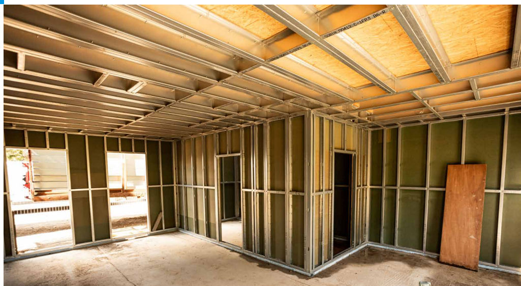
▲ Alle panelen zijn dragend, wat toelaat om grote overspanningen te realiseren.
