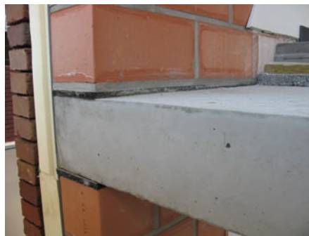
Abb. 2 Die elastischen Streifen (auf den Fotos in Schwarz) sorgen dafür, dass die Betonbodenplatten vom Rest der Konstruktion akustisch entkoppelt werden.
