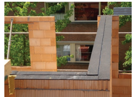
Abb. 2 Die elastischen Streifen (auf den Fotos in Schwarz) sorgen dafür, dass die Betonbodenplatten vom Rest der Konstruktion akustisch entkoppelt werden.
