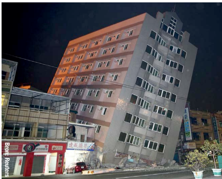
2 | Appartementengebouw waarvan de funderingsplaat gekanteld is ten gevolge van de liquefactie en de daaropvolgende verzakking van de grond tijdens de aardbeving in Taiwan van februari 2016.
