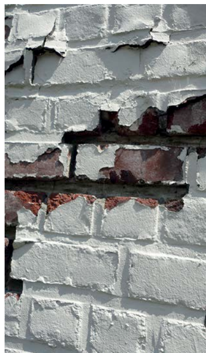
2 | Voorbeeld van schade ten gevolge van vochtophoping in de baksteen: loskomen van de verf en vorstschade ter hoogte van de voegen en de baksteen
