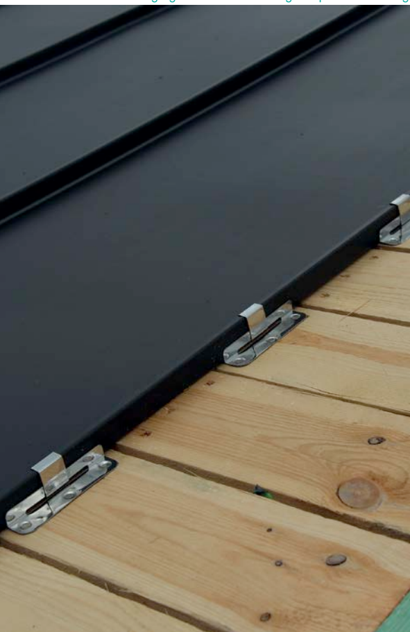
Bevestiging van de schuifklanken op de bebording
