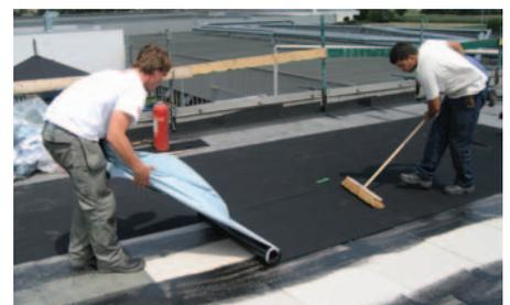
**Abb. 2 Verlegung der Bahnen mit Längsfuge auf der oberen Rippe.**
