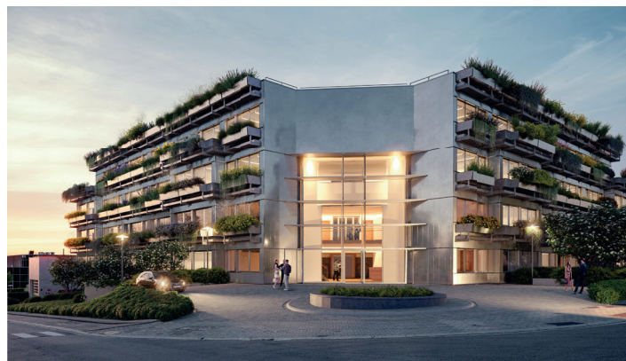
Dans le cadre d'un seasonal commissioning contract, Boydens Engineering et SECO assureront, au cours de la première année, un suivi approfondi des mesures et des installations.
