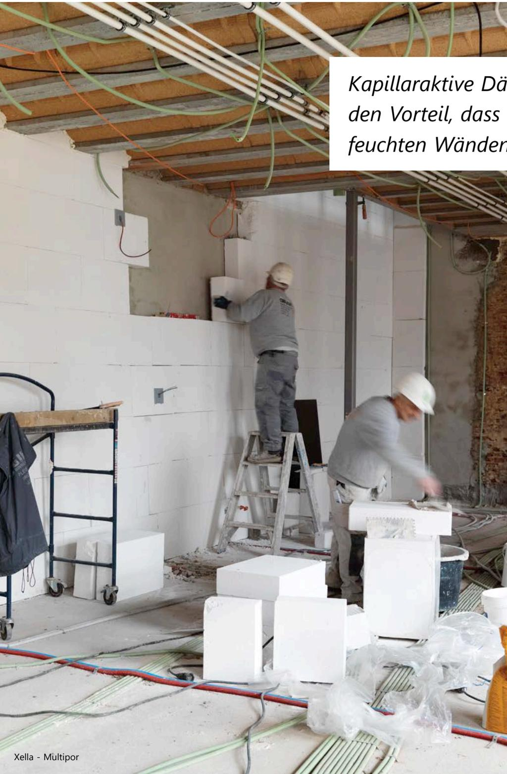
*Kapillaraktive Dämmsysteme haben den Vorteil, dass sie die Trocknung von feuchten Wänden nach innen zulassen.*
