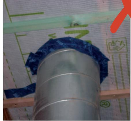
Abb. 8 Tangentiale Anbringung der Klebebänder (nicht zu empfehlen).
