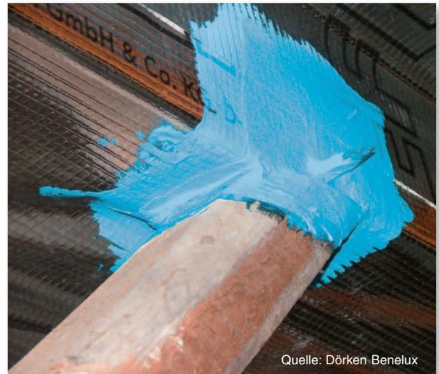
Abb. 2 Aufbringung eines flüssigen Dichtungsmittels.
