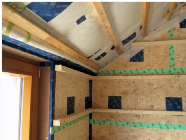
Abb. 1 Die Verbindungsstellen und Durchführungen in der Innenverkleidung aus Holzplatten werden mit Hilfe von Klebebändern abgedichtet.
