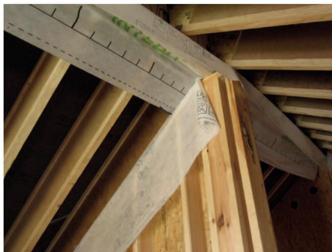
**Abb. 6 Anschluss zwischen einer Innenwand und einer Firstpfette. Die Durchgängigkeit der luftdichten Sperre wird durch eine vorverlegte Membran gewährleistet.**
