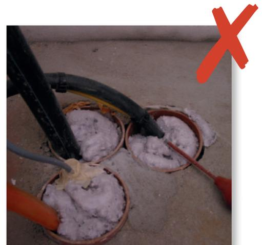
**Abb. 5** Für den Durchmesser der Leitungen ungeeignete Kabelschutzrohre.
