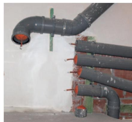
Abb. 2 Vorzugsweise ist die luftdichte Sperre vor der Anbringung der Leitungen entlang der gemauerten Außenwand auszuführen.
