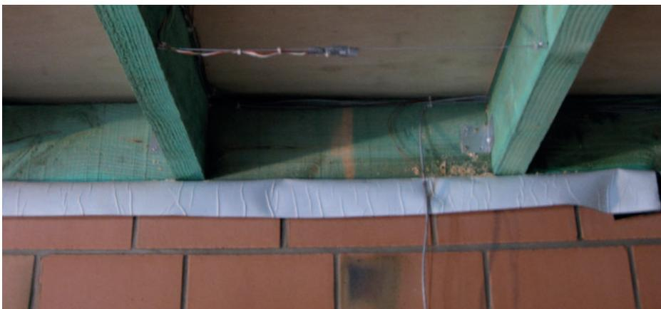
Abb. 2 und 3 Verlegung einer Membran im Fall von Balken auf Mauerwerk (die Abstandshalter aus Holz, die die Balken trennen, können eventuell durch Mauerwerk ersetzt werden).
