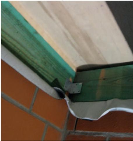
**Abb. 4 und 5** Verlegung einer Anschlussmembran im Fall von entlang der Wand verlegten Balken (ohne Verankerung).
