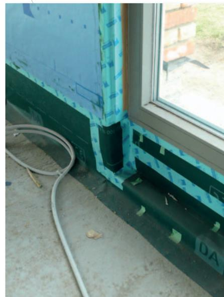
Abb. 2 Anschluss zwischen einer Holzskelettwand und einer Betonplatte mit Hilfe einer synthetischen Membran.
