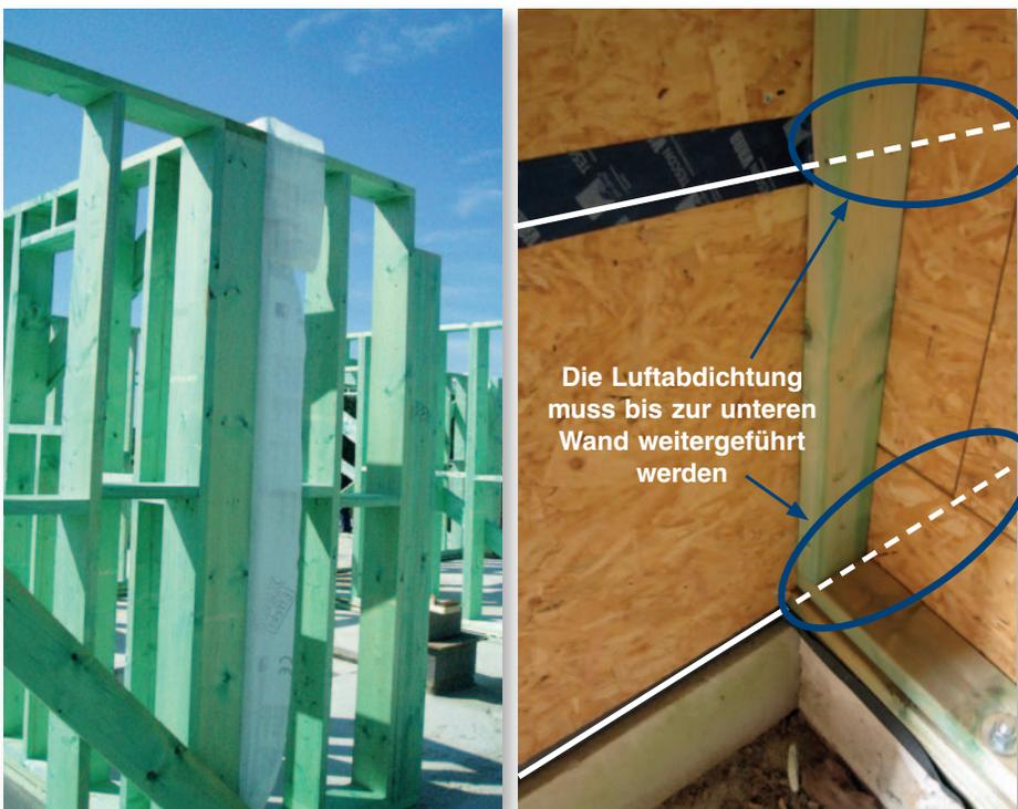
Abb. 4 Dichter Anschluss zwischen einer Innenwand und einer Außenwand mit einer Membran (links) und einer durchgehenden Verkleidung aus Platten (rechts).
