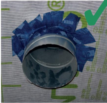
Abb. 7 Radiale Anbringung der Klebebänder (zufriedenstellende Lösung).
