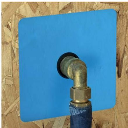
**Abb. 4** Innen auf die OSB-Platte geklebte Manschette.
