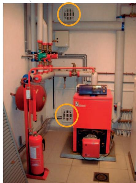
Abb. 1 Belüftung des Einbauraumes.
