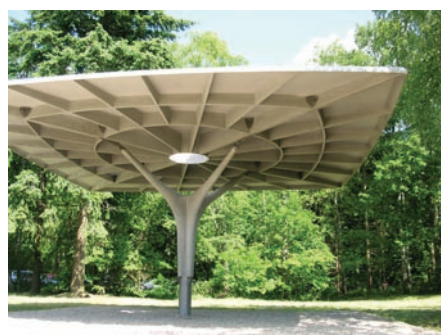
Afb. 2 De 'Zonnestraal' te Hilversum : voorbeeld van een geprefabriceerde constructie uit architectonisch UHSB.
