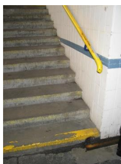
FIGUUR 57: EEN VOORBEELD VAN SLIJTAGE VAN DE TREDENEUS
