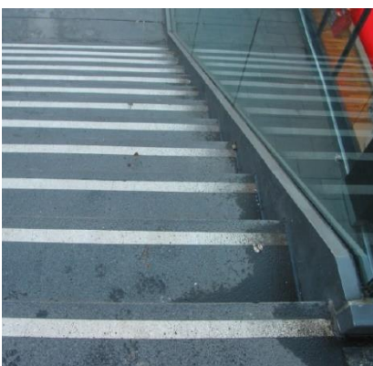
FIGUUR 41: DE MARKERING VAN DE TREDENEUS IS NAAR ACHTEREN GEPLAASTST TEN OPZICHTE VAN DE VOORZIJDEN VAN DE TREDE, WAARDOOR DIE POSITIE MINDER DUIDELIJK WORDT
