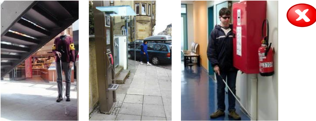
FIGUUR 51: ENKELE SLECHTE VOORBEELDEN: (1) DE RUIMTE ONDER DE TRAP IS NIET AFGESCHERMD (2) DE GLAZEN WAND VAN DE TELEFOONCEL IS ZELFS VOOR PERSONEN MET GEWOON ZICHT MOEILIK HERKENBAAR (3) DE BRANDHASPEL VORMT EEN OBSTAKEL
