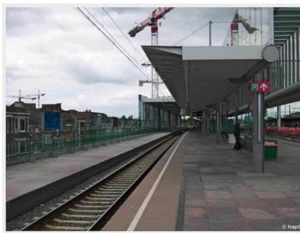
FIGUUR 53: VOORBEELD VAN EEN CONTRASTERENDE STRIP VAN 10 CM BREED GEPLAATST NAAST DE NOPPENTEGEL (STATION GENT-SINT-PIETERS)
