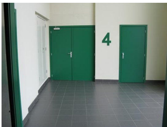
FIGUUR 26: DEUREN DIE TOEGANKELIJK ZIJN CONTRASTEREN, ANDERE DEUREN KRIJGEN DEZELFDE KLEUR ALS DE WAND
