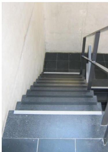
FIGUUR 38: GOEDE CONTRASTMARKERING BOVEN EN ONDERAAN DE TRAP, DE OVERIGE MARKERINGEN ZIJN MINDER GOED ZICHTBAAR
