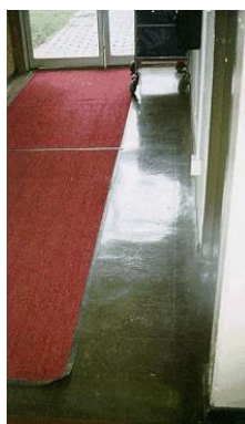
FIGUUR 18: SLECHT VOORBEELD: LOSLIGGEND TAPIJT EN GLANS HEEFT EEN NEGATIEF EFFECT OP DE CONTRASTWAARNEMING
