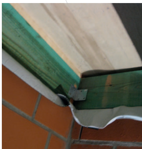
Afb. 4 en 5 Voorzien van een wachtfolie indien de niet-opgelegde draagbalken in de langsrichting naast de wanden geplaatst worden (zonder verankering).
