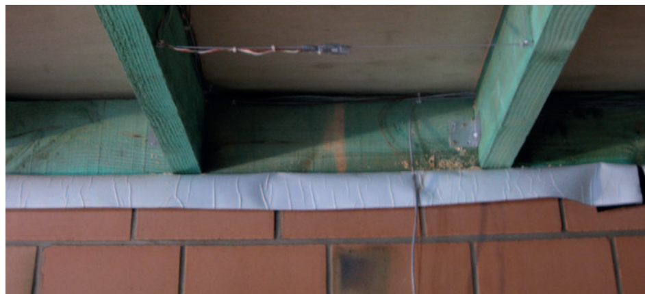
Afb. 2 en 3 Voorzien van een wachtfolie indien de draagbalken op het metselwerk opgelegd worden (de houten klossen tussen de draagbalken kunnen eventueel ook met metselwerk opgevuld worden).
