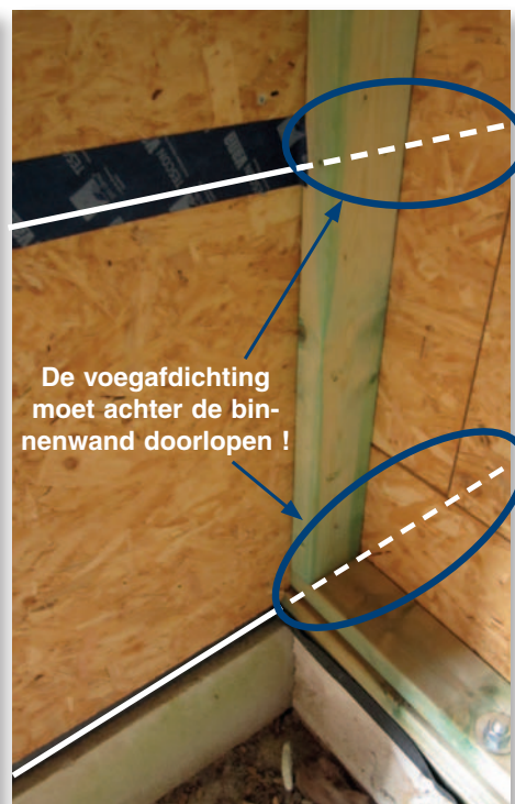
Afb. 4 Luchtdichte aansluiting van een binnenwand op een buitenwand met een wachtfolie (links) en met een doorlopende beplating (rechts).
