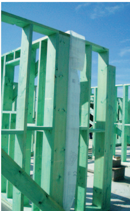
Afb. 4 Luchtdichte aansluiting van een binnenwand op een buitenwand met een wachtfolie (links) en met een doorlopende beplating (rechts).
