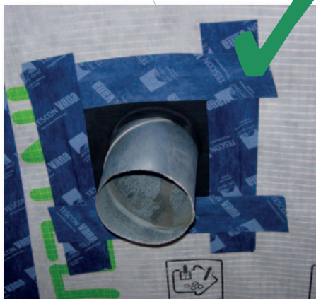
Afb. 6 Gebruik van een voorgedrukte vorm voor een ventilatieleiding (goede oplossing).
