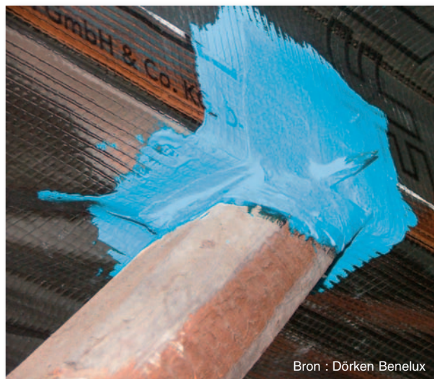
Afb. 2 Aanbrengen van een vloeibare afdichting.
