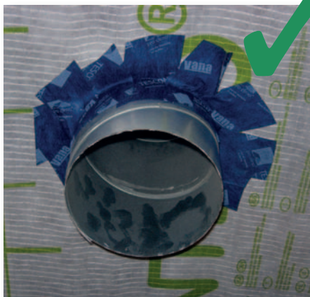
Afb. 7 Radiale plaatsing van de kleefband (bevredigende oplossing).
