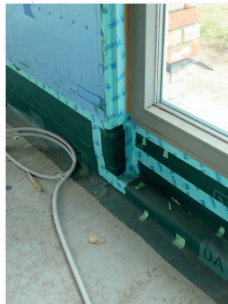
Afb. 2 Aansluiting van een houtskeletwand op een betonnen vloerplaat door middel van een strook kunststoffolie.
