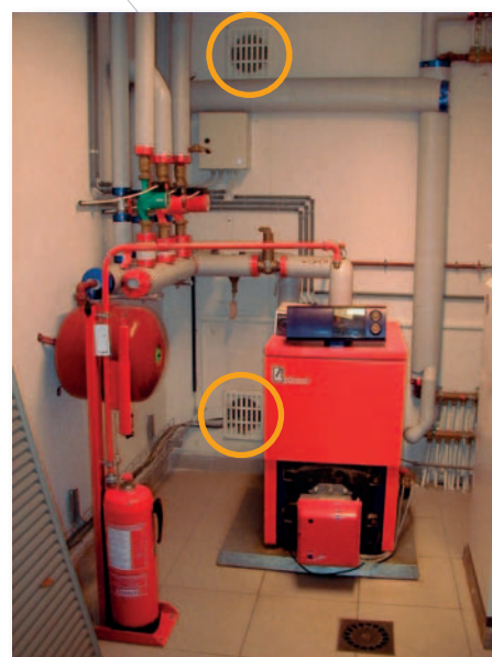
Afb. 1 Ventilatie van de opstellingsruimte.
