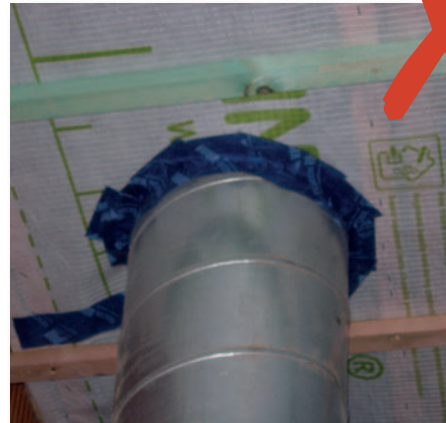
Afb. 8 Tangentiële plaatsing van de kleefband (af te raden oplossing).
