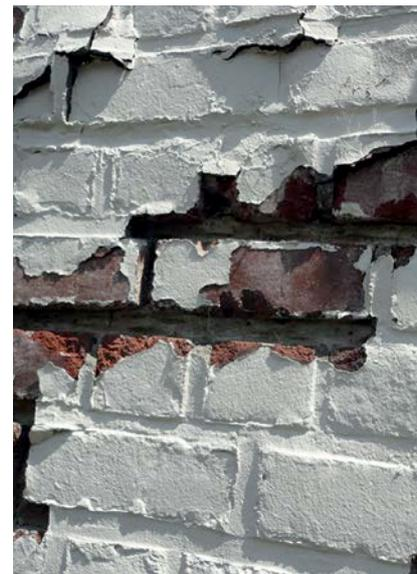
2 | Beispiel für einen Schaden aufgrund einer Feuchtigkeitsansammlung im Ziegelstein: Ablösung des Anstrichs und Frostschäden in Höhe der Fugen und des Ziegelsteins
