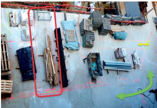
Beispiel für den Einsatz des Hilfsmittels Visuelles Management und der 5S-Methode zur besseren Organisation der Lagerfläche auf der Baustelle. Die Verkehrsbereiche wurden durch Pfeile angedeutet.
