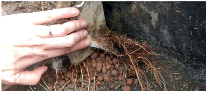
2 | Wurzeln, die die Dichtungsmembran von Dach Nr. 7 erreicht haben
