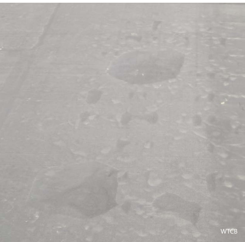
1 | Blaasvorming tussen de thermische isolatie en haar cachering.
