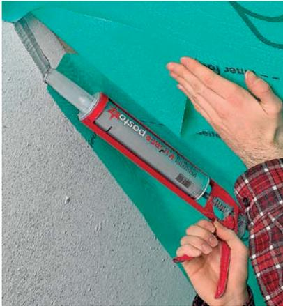
10 | Beispiel für einen Anschluss ‚trocken auf trocken‘.
