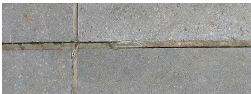
1 | Microscheurtjes ter hoogte van de voegen van een natuurstenen betegeling
