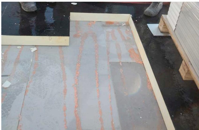
2 | La dispersion de l'humidité dans le complexe toiture rend la détection des infiltrations difficile.
