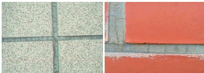
1 et 2 | Microfissures de retrait des joints d'un dallage et d'une maçonnerie
