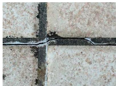
3 | Fissures générées par des dilatations hygrothermiques et/ou des mouvements du support
