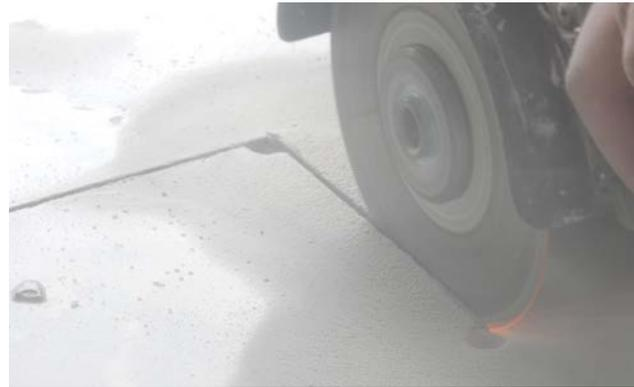
2 | Réalisation d'une réservation rectangulaire en forant des trous dans les angles et en les reliant ensuite au moyen d'une disqueuse
