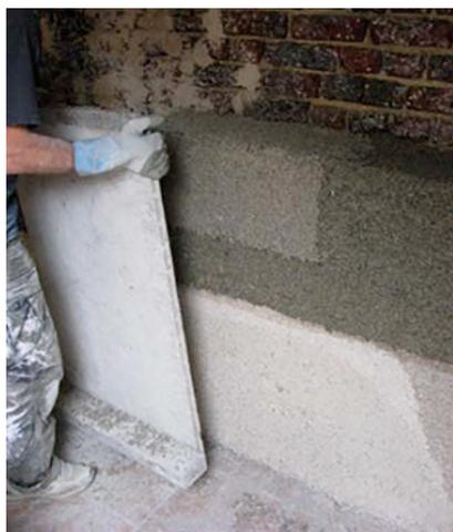
1 | Banchage d'un mélange liant-chanvre pour la réalisation d'un contre-mur
