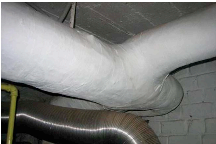
4 | De aanwezigheid en de staat van de isolatie moeten nagegaan worden.
