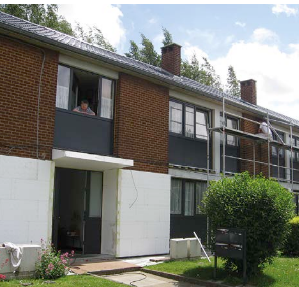
1 | Isolatie langs de buitenzijde van bestaande muren
