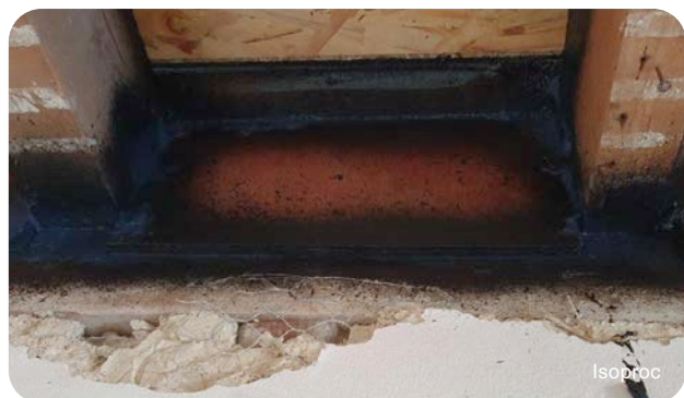
3 4 Afdichting van doorvoeringen doorheen het daktimmerwerk met behulp van een aangepaste tape (links) of een vloeibare afdichting (rechts).
