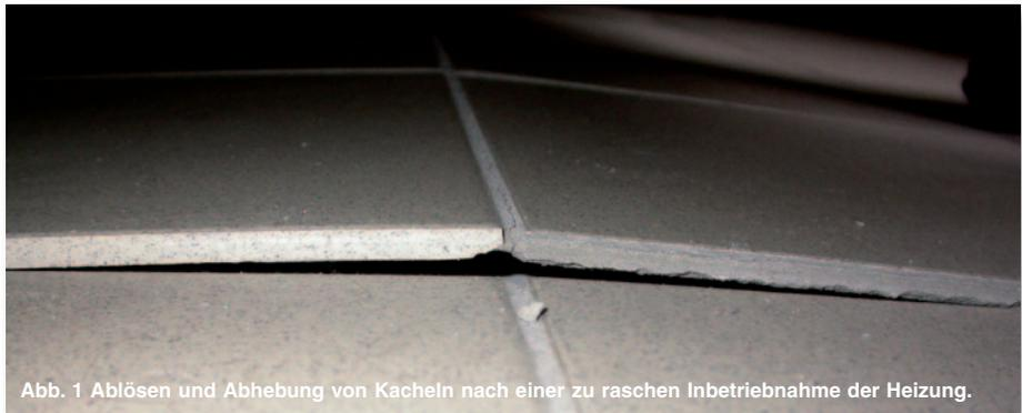
Abb. 1 Ablösen und Abhebung von Kacheln nach einer zu raschen Inbetriebnahme der Heizung.
