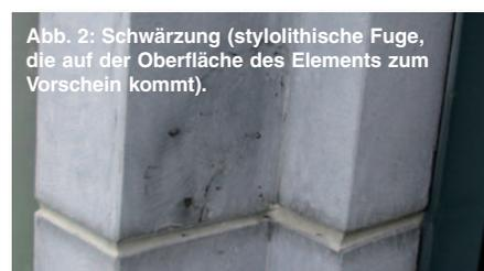
Abb. 2: Schwärzung (stylolithische Fuge, die auf der Oberfläche des Elements zum Vorschein kommt).
