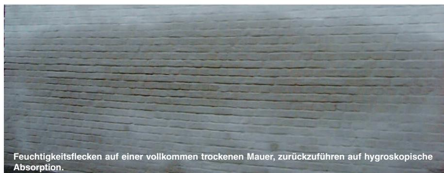
Feuchtigkeitsflecken auf einer vollkommen trockenen Mauer, zurückzuführen auf hygroskopische Absorption.
