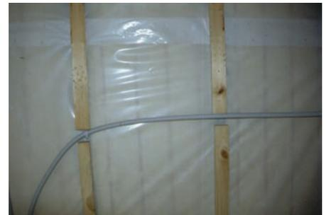
**Abb. 4 Leitungskanal entlang der Innenseite der Lufthülle.**
