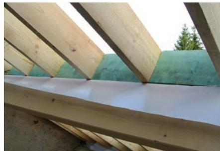
**Abb. 3 PE-Folie, angebracht während der Errichtung der Dachsparren.**
