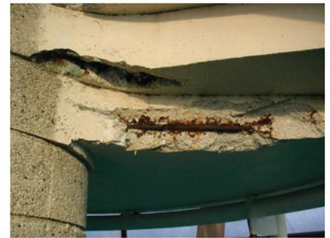
**Abb 2** Korrosion der Betonarmierung.
