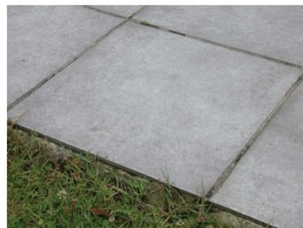
Fig. 1 Terrasse directement en contact avec le terrain.
