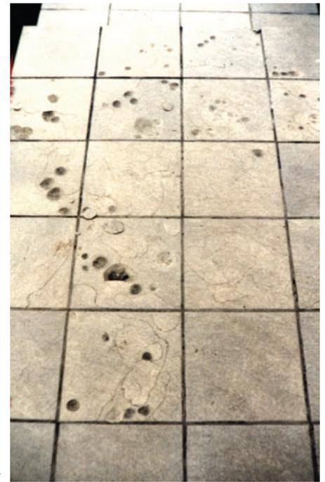
Fig. 5 Dégâts de gel observés sur une terrasse extérieure. ▶
