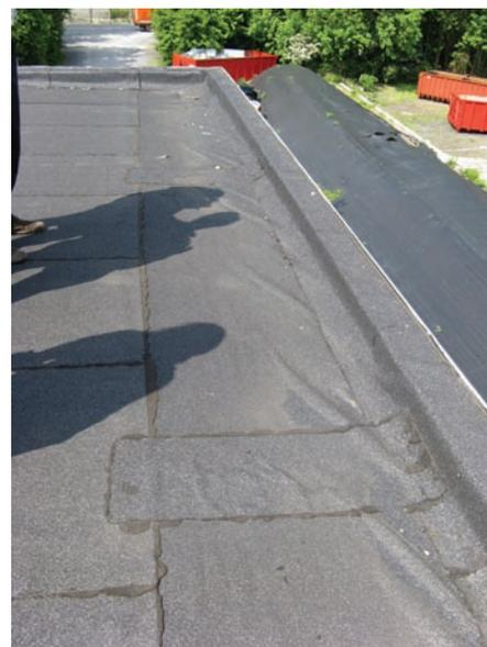
Fig. 1 Ondulation de l'étanchéité d'une toiture.
