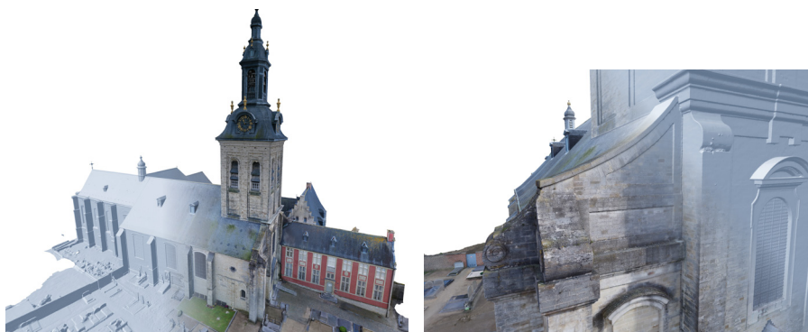
Links: 3D-mesh van de Abdy van Park, Leuven, gemaakt met foto's van een minidrone en fotogrammetriesoftware. Rechts: detail van de ornamenten.
