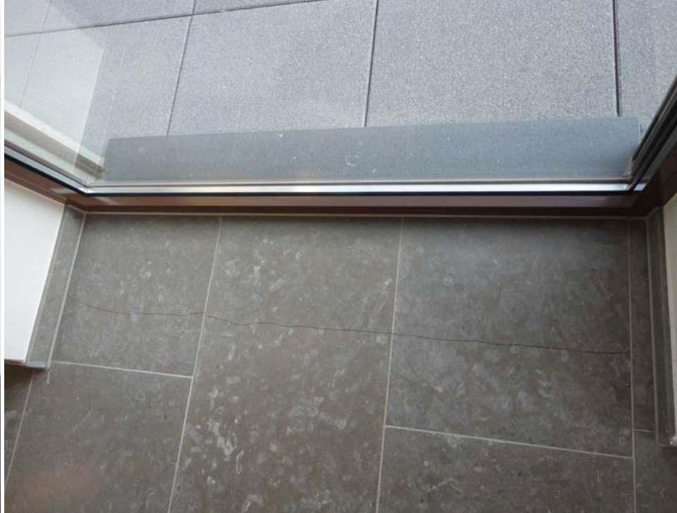
2 et 3 | Fissure dans un dallage à proximité d'une fenêtre posée sur des blocs isolants (voir figure 4). La fissure se manifeste dans le prolongement de la face intérieure des blocs.
