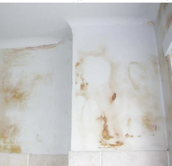
1 et 2 | Apparition de taches d'humidité dans un parachèvement intérieur et le long d'un conduit de fumée
