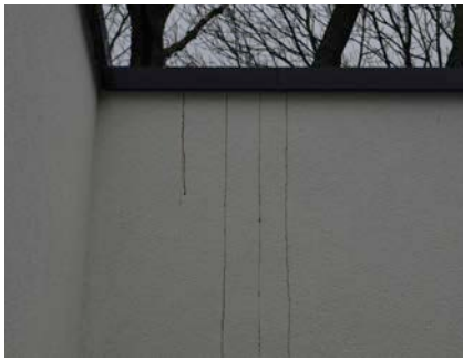
6 et 7 | Apparition de coulures brunâtres dues à la production de condensation au droit des couvre-murs
