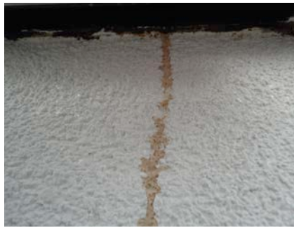
6 et 7 | Apparition de coulures brunâtres dues à la production de condensation au droit des couvre-murs
