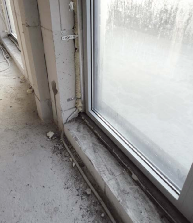
2 et 3 | Fissure dans un dallage à proximité d'une fenêtre posée sur des blocs isolants (voir figure 4). La fissure se manifeste dans le prolongement de la face intérieure des blocs.
