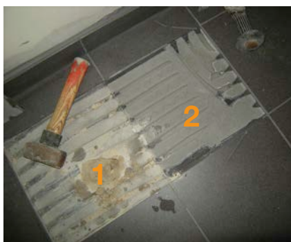
5 et 6 | Décollement d'un carrelage sur chape anhydrite
