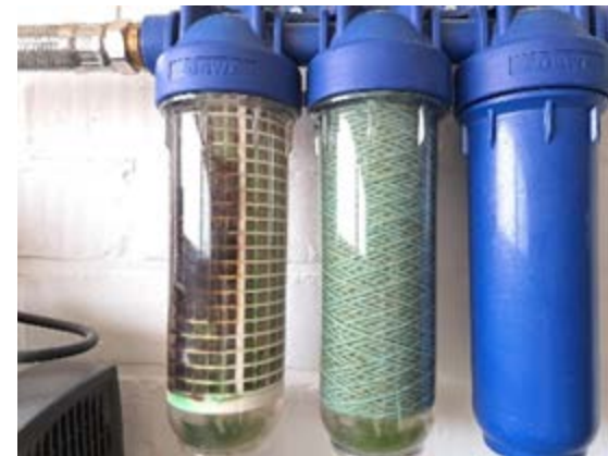
Figuur 7 Drievoudige filter (90 µm, 25 µm en actieve koolfilter)
