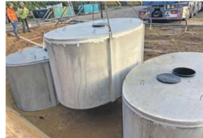
Figuur 3 Installatie van een hemelwaterput. Bron: GEP
