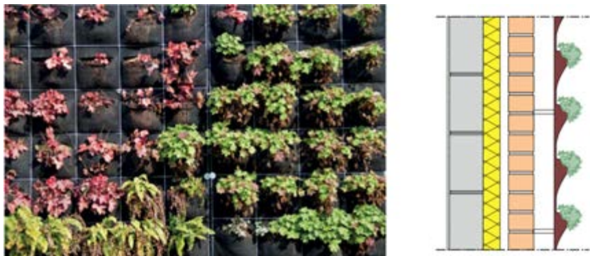
Figuur 9 Gevelgebonden groene gevel (living wall system) met plantenzakken. Bron: Begroende Gevels, Innovation Paper, Buildwise, November 2022
