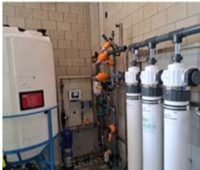
Figuur 24 Ultrafiltratie in Keiberg-Vossem
