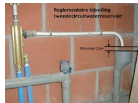
Figuur 5 Fysieke onderbreking tussen twee watercircuits
