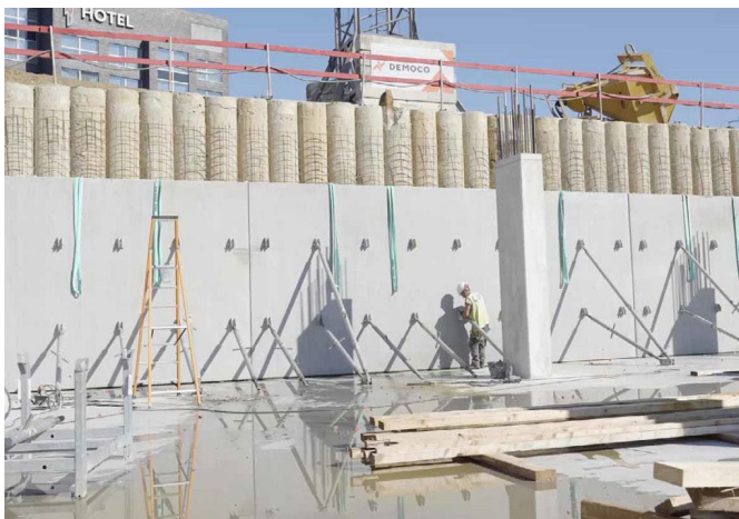
Fig. 1 : Gebruik van op maat gemaakte geprefabriceerde modules in plaats van traditionele bekisting
