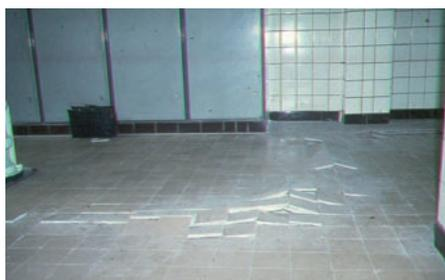
Fig. 1 Soulèvement d'un carrelage sur sable stabilisé.
