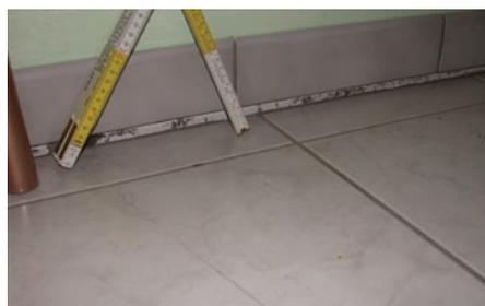
Fig. 2 Affaissement au voisinage de la plinthe.
