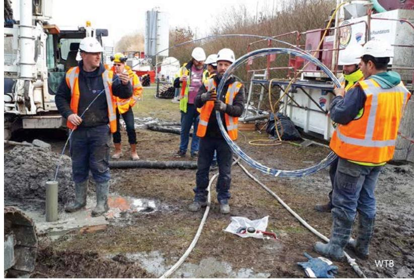
2 | Einsatz von faseroptischen Sensoren in einem bodenverdrängenden Schraubpfahl (links) und einem Mikropfahl (rechts).
