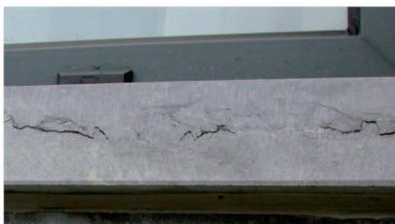
En ce qui concerne la **qualité du façonnage**, la NIT 213 précise les défauts admissibles (épaufrures, écornures, dentelures, griffures, traits de meules, fissures et éclats). Il importe de préciser dès la commande si ce type de défauts peut être corrigé moyennant un masticage soigné.
