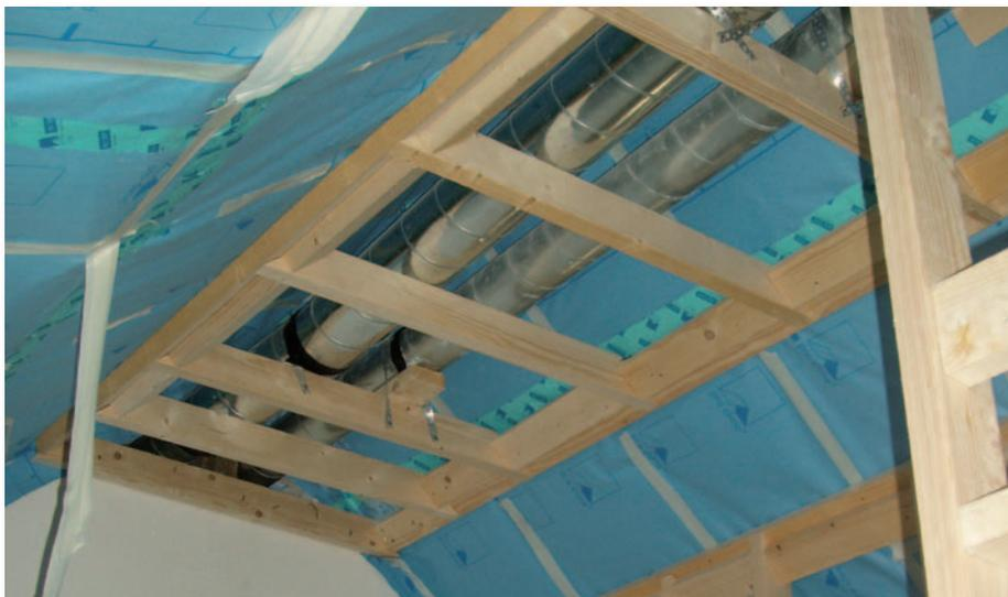
Fig. 1 Dissimulation des conduits dans des espaces perdus
