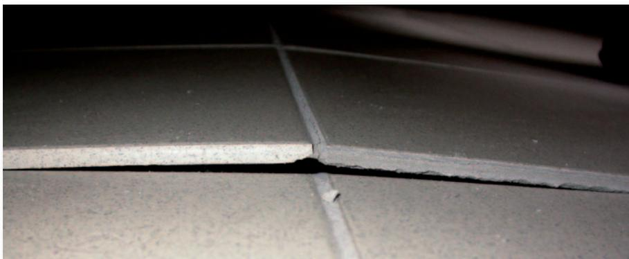
**Fig. 1** Décollement et soulèvement des carreaux après une mise en service trop rapide du chauffage
