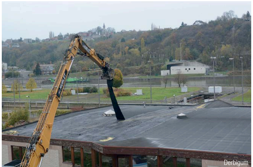
1 | Der selektive Abbruch von Dächern hat mehr Recycling zur Folge.
