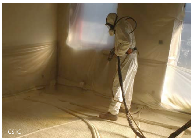
1 | Projection in situ de mousse de polyuréthane.
