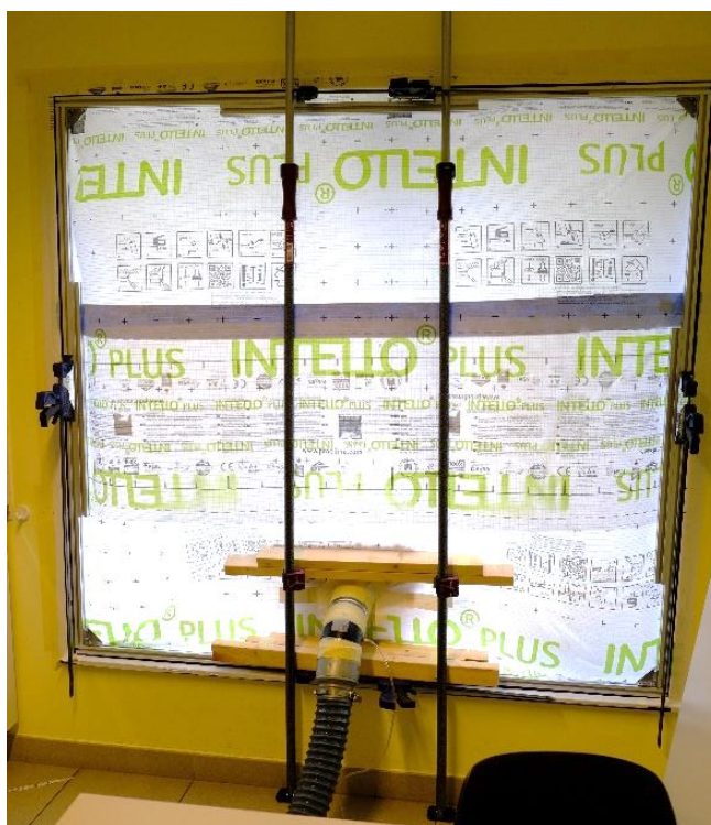
FIGURE 8. MISE EN PLACE DU DISPOSITIF DE MESURE POUR LE CHÂSSIS PVC À LIMELETTE
