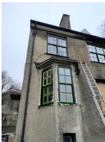
FIGURE 4. FAÇADE AVANT DE LA MAISON TESTÉE
