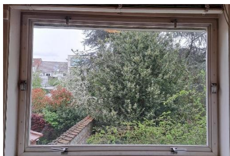
FIGURE 14. OUVERTURE BASCULANTE HORIZONTALE, 4 GÂCHES, TESTÉ IN-SITU
