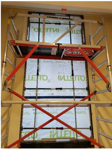
FIGURE 20. MISE EN PLACE DU DISPOSITIF DE MESURE POUR L'UNE DES FENÊTRES DE LA MAISON
