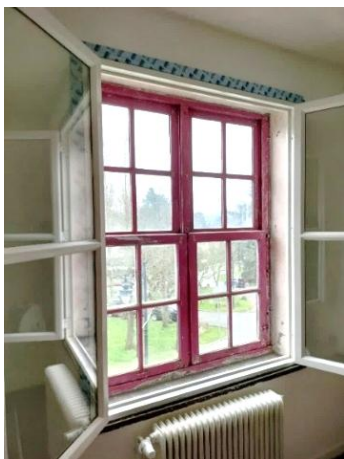
FIGURE 3. DOUBLE CHÂSSIS CÔTÉ INTÉRIEUR
