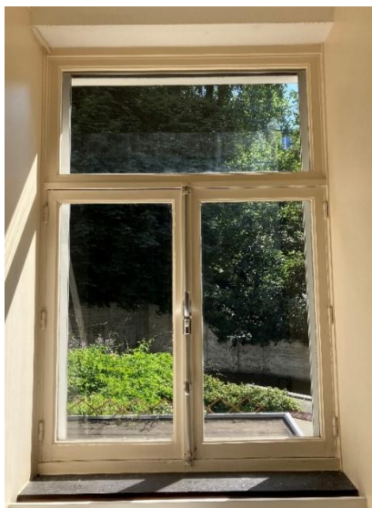
FIGURE 12. MISE EN PLACE DU DISPOSITIF DE MESURE POUR LA FENÊTRE RUE TIMMERMANS, 84
