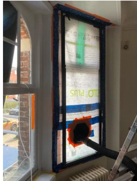
FIGURE 208. MISE EN PLACE DU DISPOSITIF DE MESURE POUR LA FENÊTRE À WATERLOO
