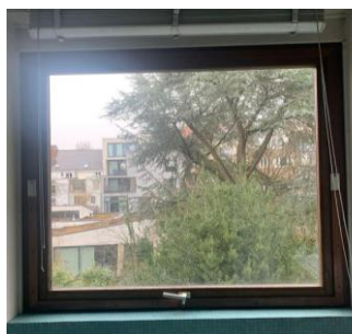
FIGURE 15. OUVERTURE BASCULANTE HORIZONTALE, 6 GÂCHES, TESTÉ IN-SITU
