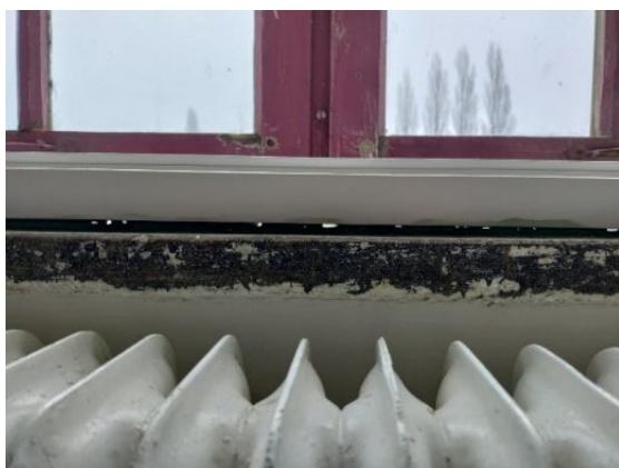
FIGURE 6 – JOINT MAL REALISE ENTRE LA TABLETTE ET LE CHÂSSIS
