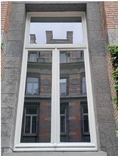
FIGURE 219. DOUBLE OUVRANT AVEC IMPOSTE FIXE (BOIS), OUVERTURE EN GUEULE DE LOUP, TESTÉ IN-SITU
