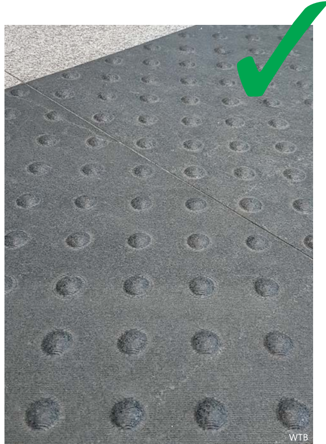
2 | Die Noppen der angrenzenden Bodenplatten müssen genau in einer Linie liegen und die gleichen Abmessungen aufweisen.
