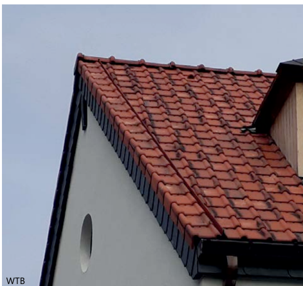
1 | Abschluss der Dachränder mit Ortgangziegel.
