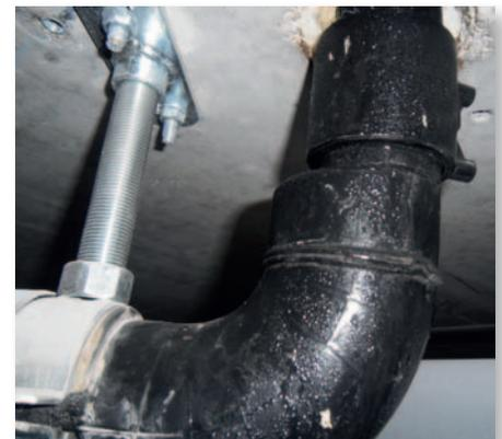
**Abb. 3** Bildung von Kondenswasser auf einer Regenabwasserleitung.
