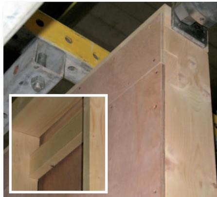
Abb. 1 Abschlussleiste (Sicht von vorne und, im kleinen Fenster, von der Rückseite).
