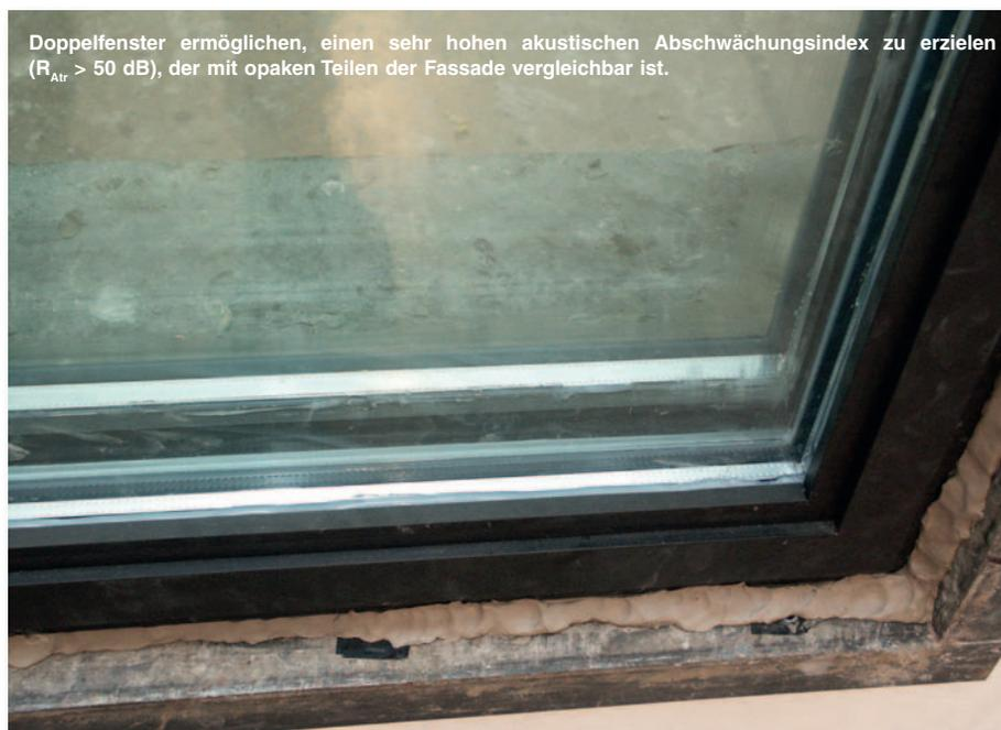
Doppelfenster ermöglichen, einen sehr hohen akustischen Abschwächungsindex zu erzielen ( $R_{Atr} > 50$  dB), der mit opaken Teilen der Fassade vergleichbar ist.
